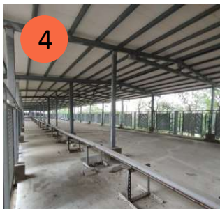
A棟 頂樓3樓
